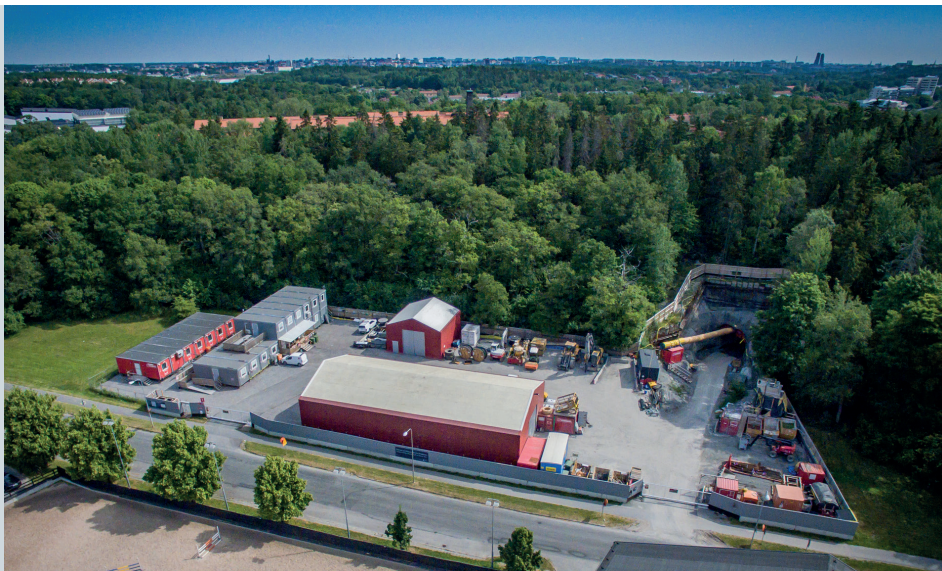
Byggetableringen i Åkeshov ligger mitt emot Åkeshovs ridhus. En 250 meter lång arbetstunnel har byggts ner till avloppstunneln, 27 meter under Mälarens nivå.
