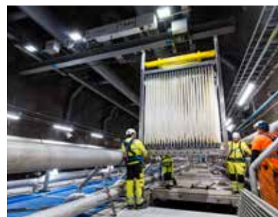
Foto från installationen av de första Membrankassetterna i juni 2020
