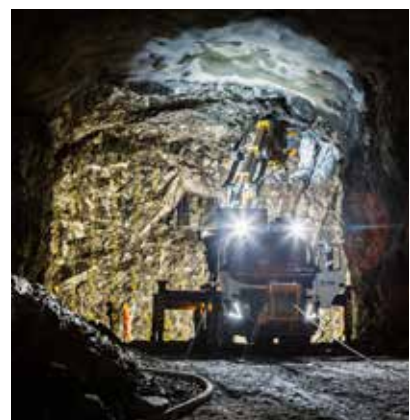
Laddning inför sprängning, Sicklaanläggningen under Hammarbybacken
