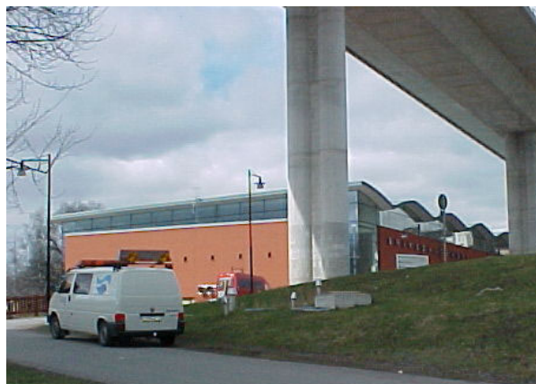
Bild 2.2 Vy norrut under Johanneshovsbron. Nedstigningsbrunnar till magasinet i grässlätten.
