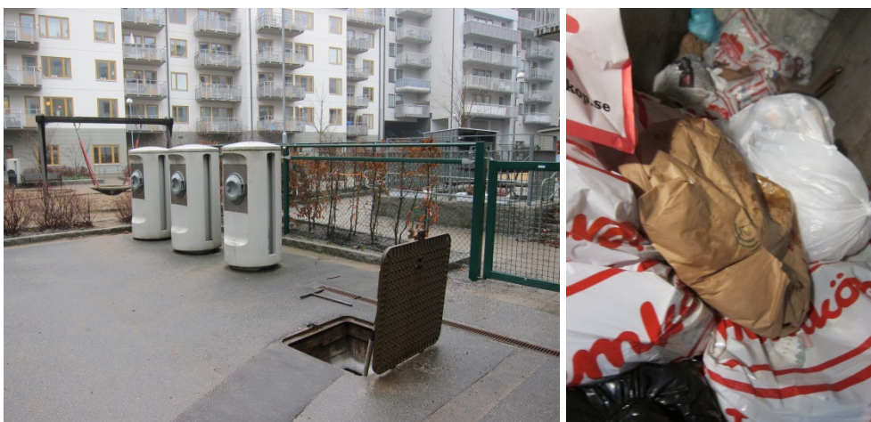
Bild 5. TV inkast och manlucka; TH i tank innan tömning
