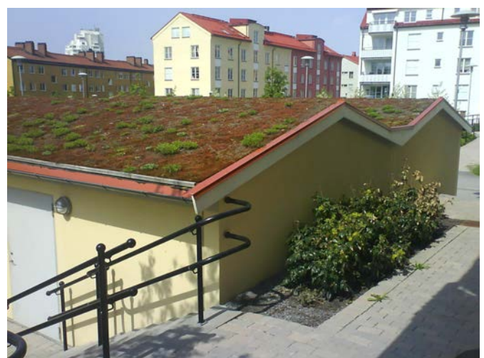
Gröna tak på garagebyggnader (Sweco).
