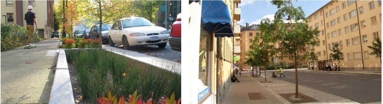
Växtbäddar för gatudagvatten (Okidoki). Trädplantering dit dagvatten från tak och trottoar leds (Trafikkontoret).
