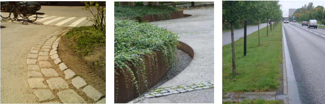
Ytlig lokal avledning (Sweco). Torgplats med uppsamling (Sweco). Vägdikey med släpp i kantsten (Stockholm Vatten).
