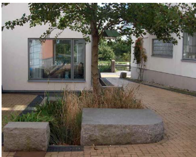
Växtbädd för hantering av innergårds dagvatten (Okidoki).
