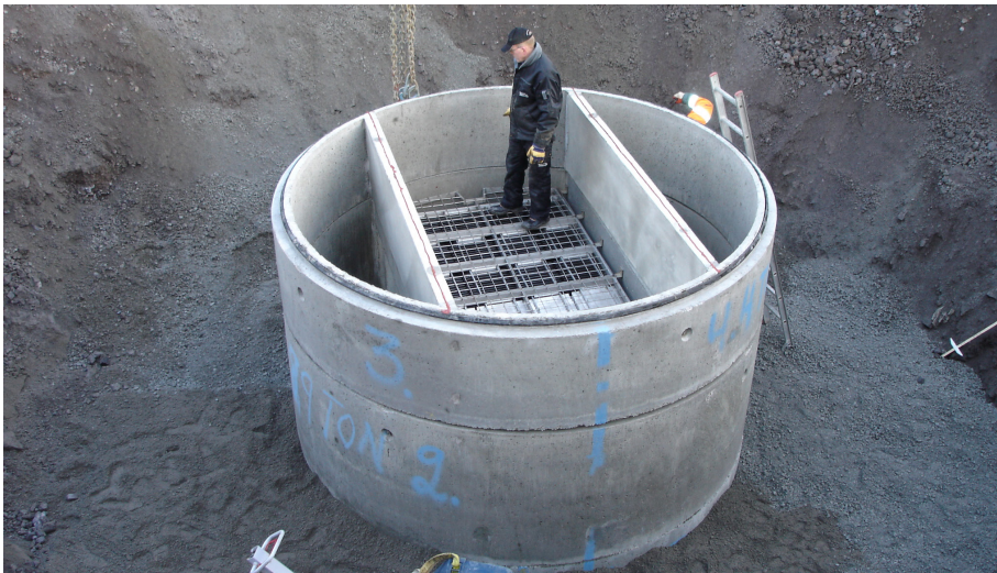
Det finns många typer av oljeavskiljare för placering under jord. Bilderna visar en stor lamelloljeavskiljare i betong under uppbyggnad. På marknaden finns även prefabricerade oljeavskiljare i plast.
