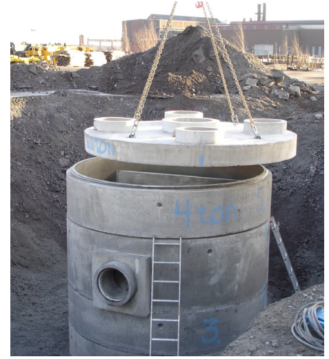
Det finns många typer av oljeavskiljare för placering under jord. Bilderna visar en stor lamelloljeavskiljare i betong under uppbyggnad. På marknaden finns även prefabricerade oljeavskiljare i plast.
