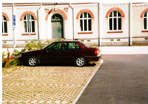
Fig. 6.3 Gräsarmering på P-plats (SVAB).
