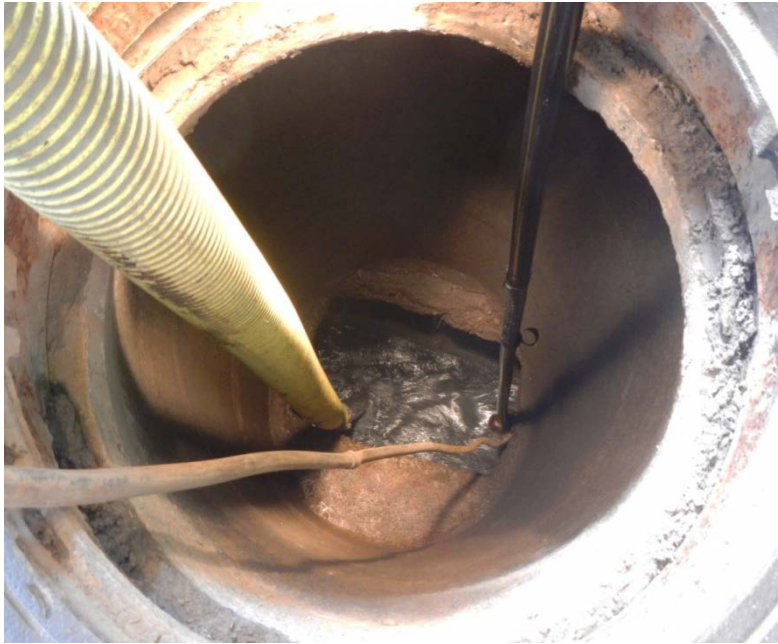
Bild 1 Spolning av ledning foto Pia Dromberg 2013
