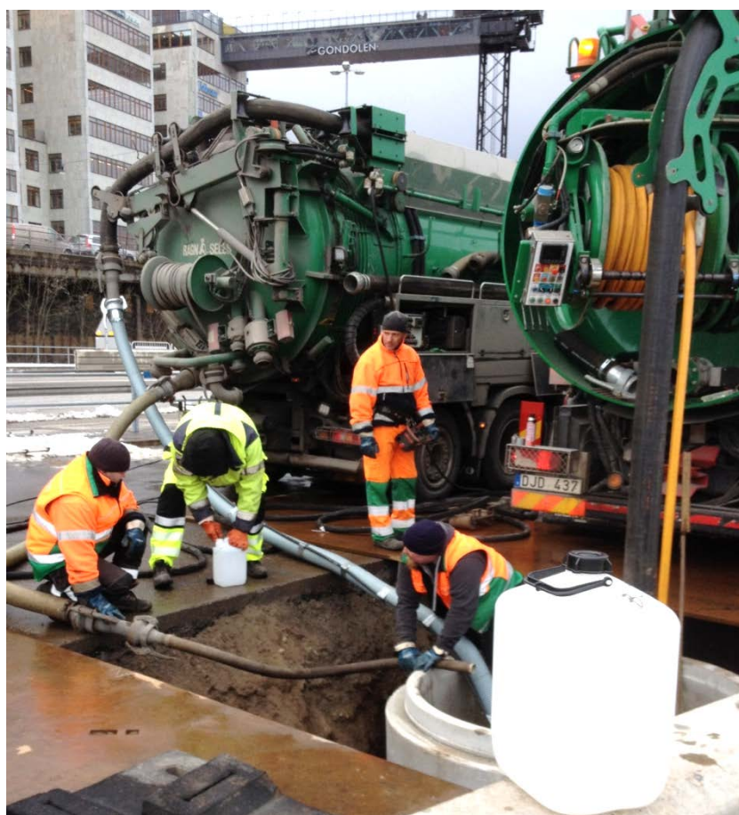
Bild 7. Spolarbete med polymermetoden vid Franska Bukten. Foto Emma Lilliesköld 2014
