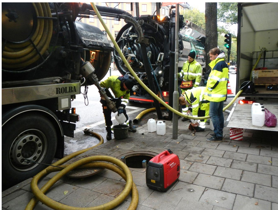
Bild 6. Försök och provtagning på Sveavägen. Gul slang från cipaxtank med polymerlösning kopplad till sugslang på spolbilen. Foto Pia Dromberg 2013.
