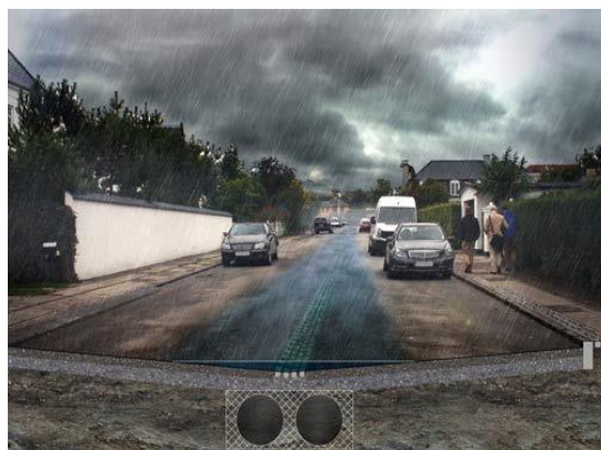
Exempel på mindre skyfallsled i urban miljö med en skyfallsväg som används både för fördröjning och transport av skyfallsvatten (Gentofte, Danmark). Källa: Ramböll
